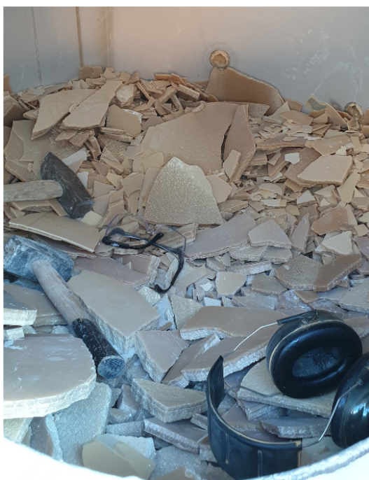
Figur 4 - (venstre) muggert, briller og høreværn anvendes ved manuel kalkfjernelse og (højre) resultat af manuel kalkfjernelse
