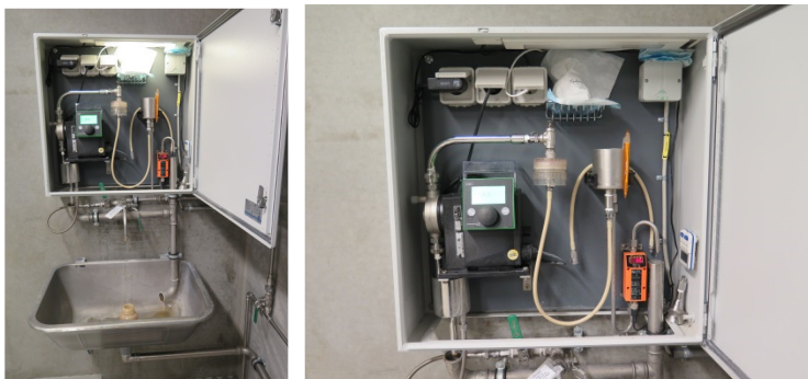
Figur 10-1: Eksempel på fastmonteret døgnprøvetager med indbygget vask
