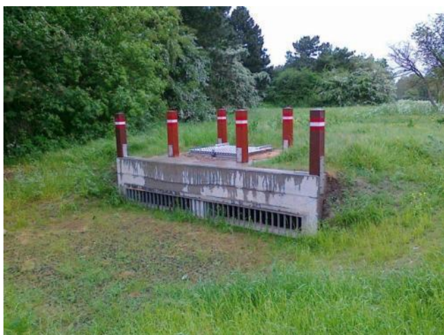
Figur 2: Eksempel på markering af dæksel i grønt område af hensyn til synlighed af dæksel i forbindelse med græsslåning
