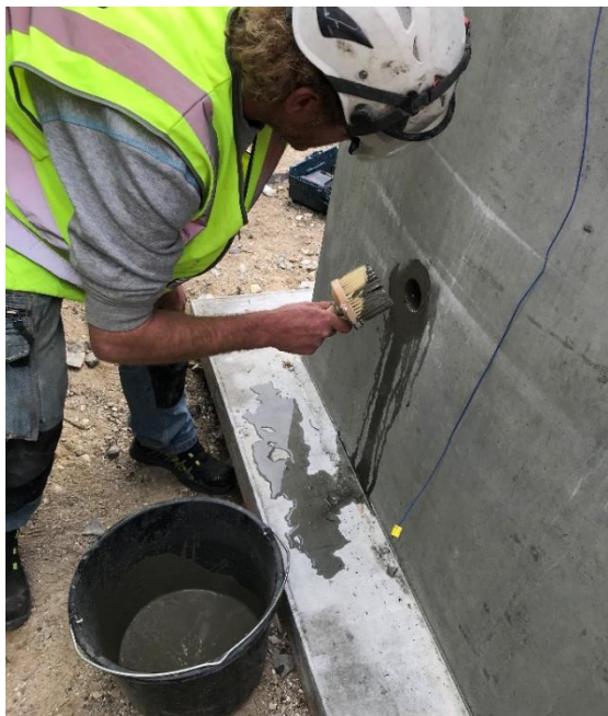
Foto 3: Inden udsætning af klamshullene svummes hullet med en svummeblanding af cement og vand
