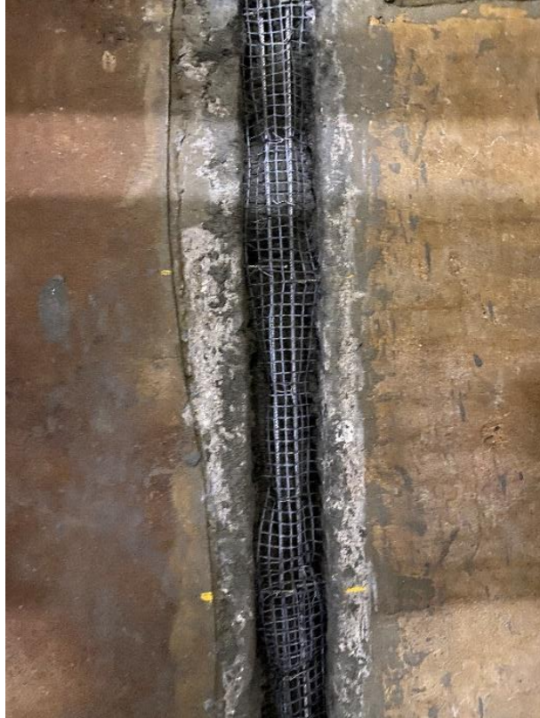
Armeringsnet er opsat
