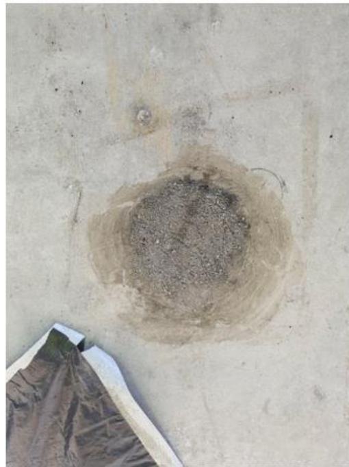
Foto 7: Udstøbningen efter 7½ døgn, hvor afdækningen lige er fjernet og udstøbningen fortsat er fugtig
