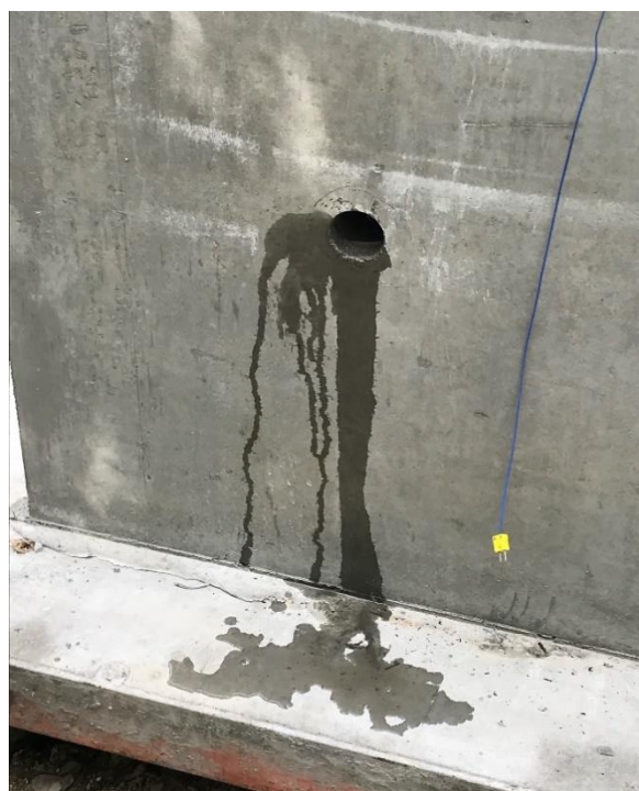
Foto 2: Klamshullet skylles med almindeligt vand, idet det sikres, at alt betonstøv er bortsøllet og betonen ikke er stærkt vandsugende
