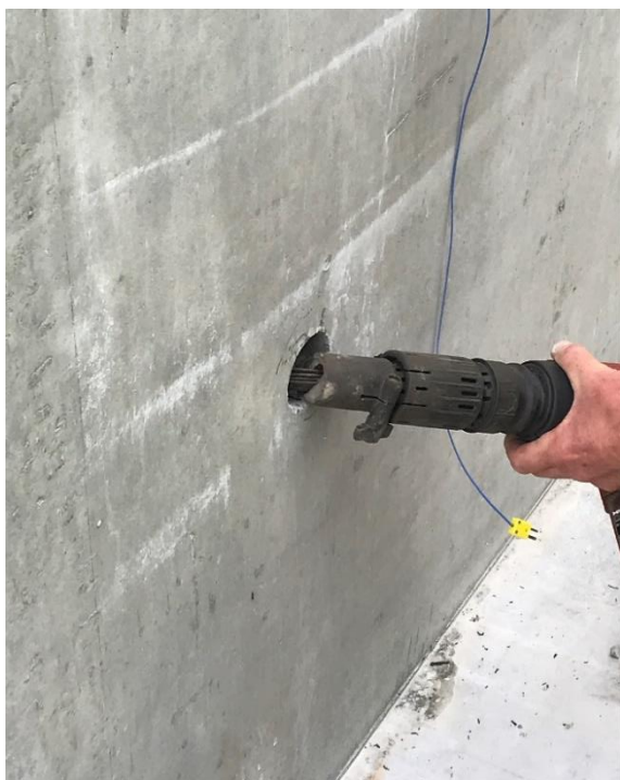
Foto 1: Den glatte støbehud i klamshullet rughugges ved anvendelse af nålehammer
