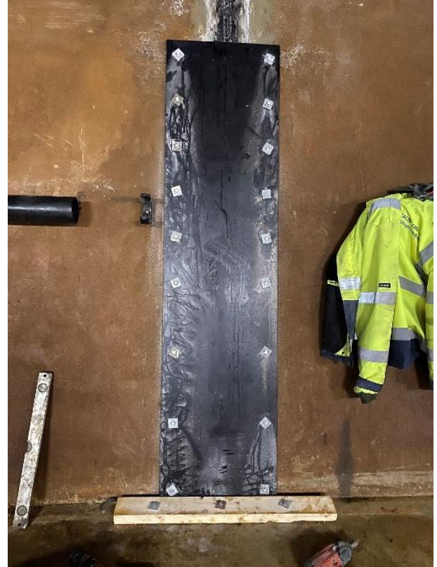
Forskalling er etableret
