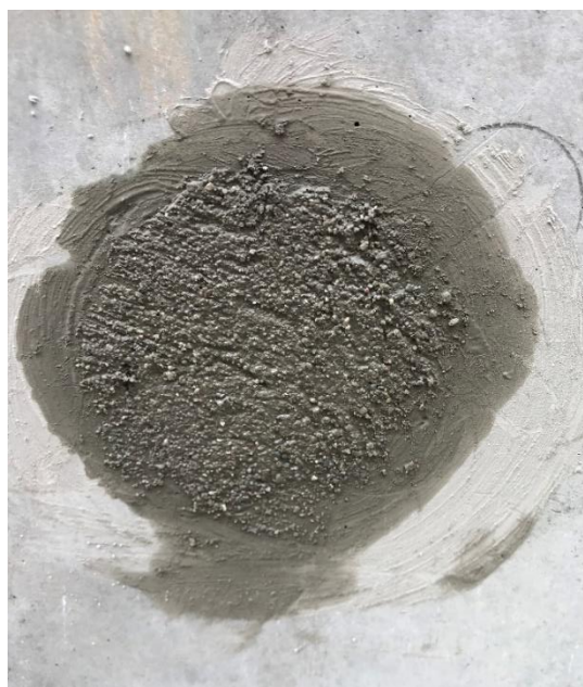
Foto 5: Overfladen afrettes således, at det lukkede klamshul er i plan med den øvrige betonoverflade
