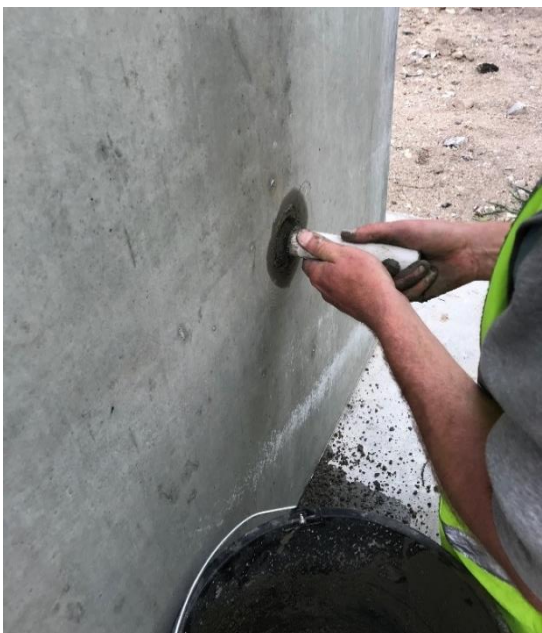
Foto 4: Klamshullet lukkes ved udsætning med cementbaseret støbemørtel og støbemørtlen komprimeres hårdt i klamshullet
