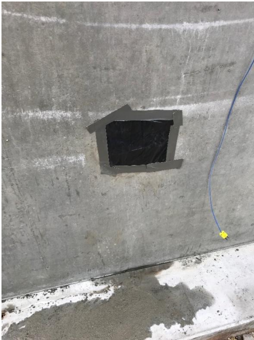
Foto 6: For at sikre udstøbningen mod hurtig udtørring, afdækkes området med tætsiddende plastik
