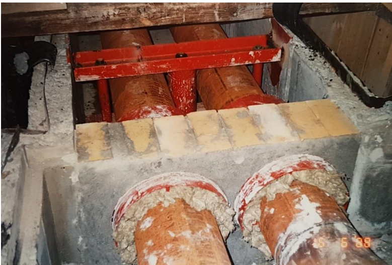
Figur 2 - Forrest: Opmuring og dobbeltbøsninger/tromlebøsninger; Bagerst: Sidestyr
